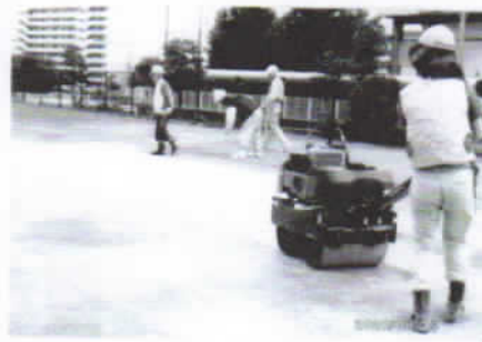
西29号棟北側公園の工事 8月25日
